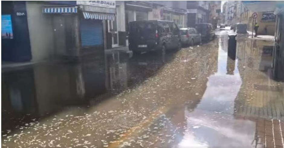
Revienta una tubería en pleno centro de La Línea y deja sin suministro varias calles.
