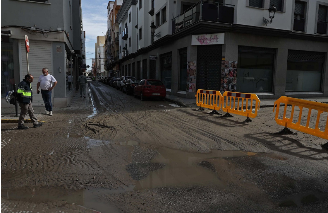
La calle Clavel, tras la rotura de una tubería este domingo.
